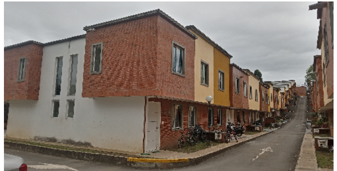
Fachada del Inmueble
