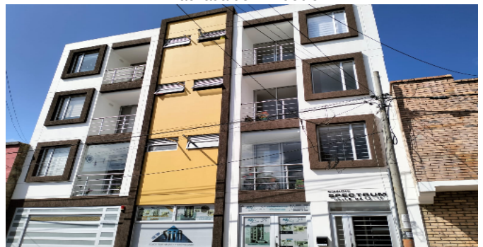
Fachada del Inmueble
