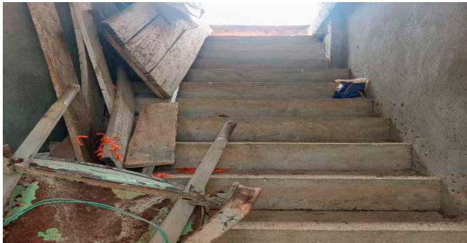
Escalera del inmueble
