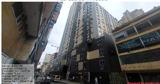
Fachada del Inmueble
