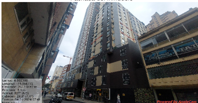
Fachada del Inmueble
