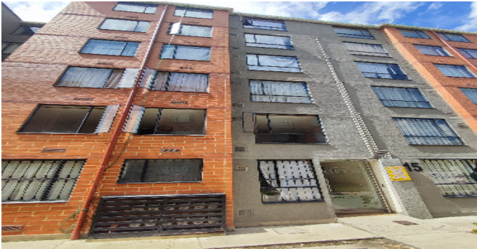
Fachada del Inmueble
