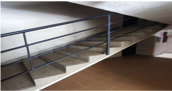
Escalera común - CJ
