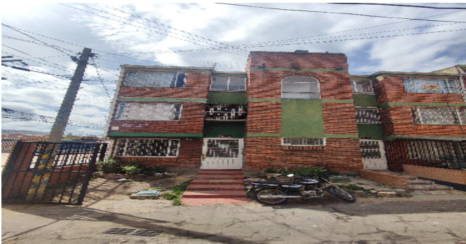
Fachada del Inmueble
