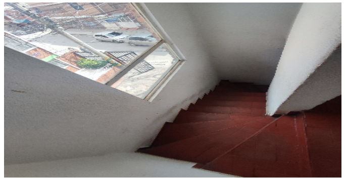
Escalera común - CJ
