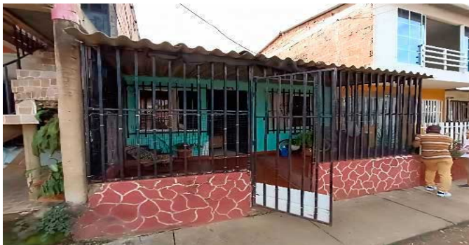
Fachada del Inmueble
