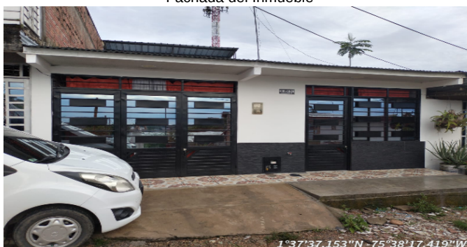
Fachada del Inmueble
