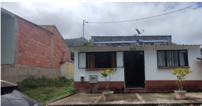
Fachada del Inmueble
