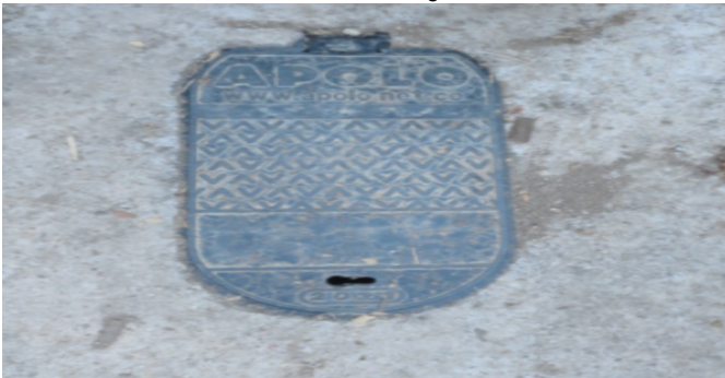
Contador de Agua
