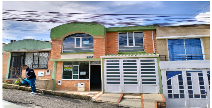
Fachada del Inmueble
