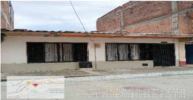
Fachada del Inmueble
