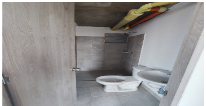
Baño Privado Hab 1
