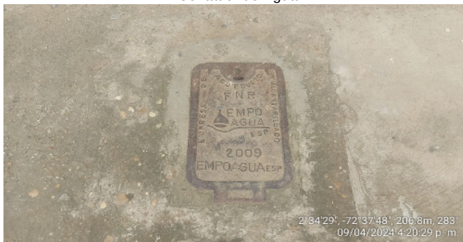
Contador de Agua
