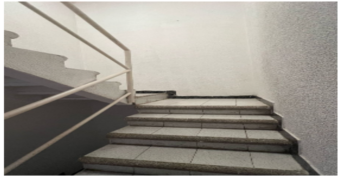
Escalera del inmueble
