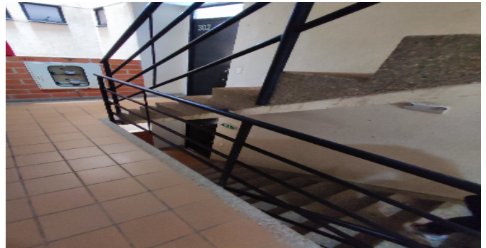
Escalera común - CJ
