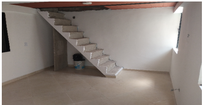
Escalera del inmueble
