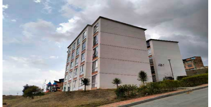
Fachada del Inmueble
