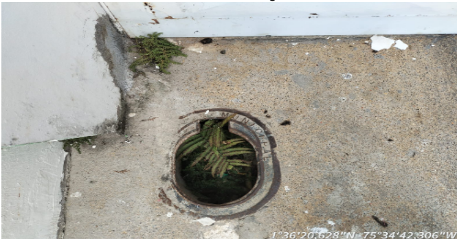
Contador de Agua
