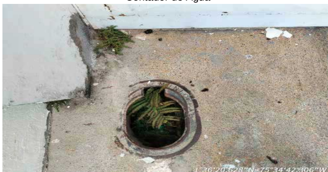
Contador de Agua
