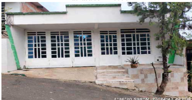
Fachada del Inmueble
