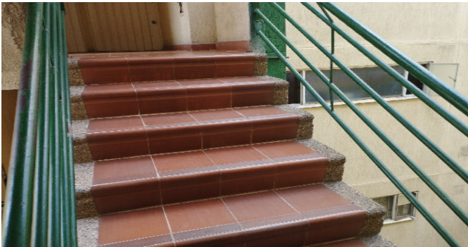
Escalera común - CJ
