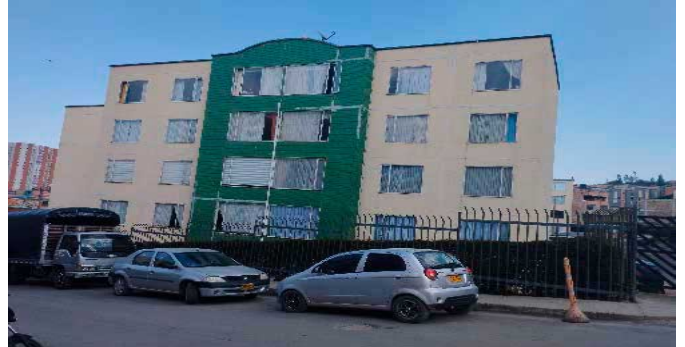
Fachada del Inmueble
