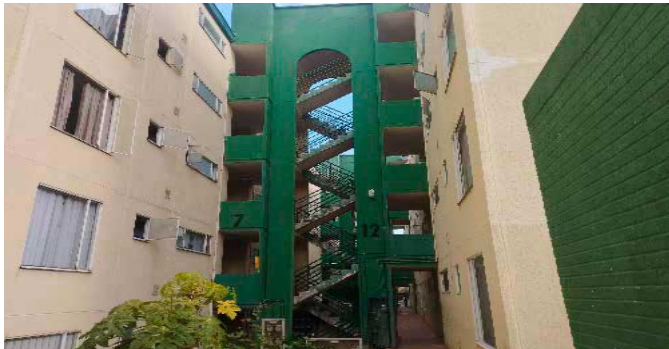
Fachada del Inmueble
