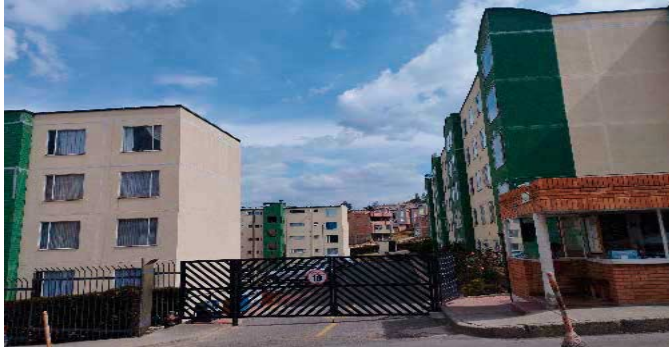
Fachada del Inmueble
