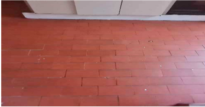
Detalle de acabados
