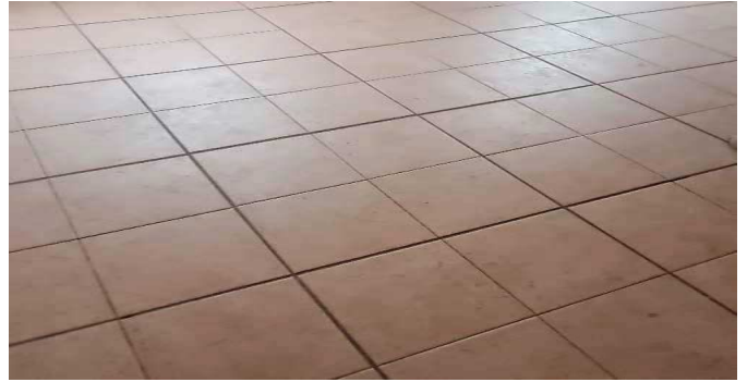
Detalle de acabados
