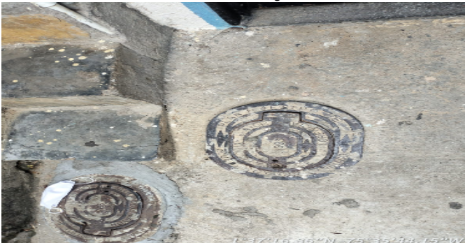
Contador de Agua
