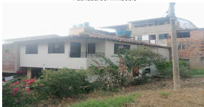
Fachada del Inmueble
