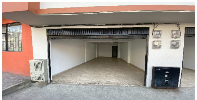
Acceso a Local 1
