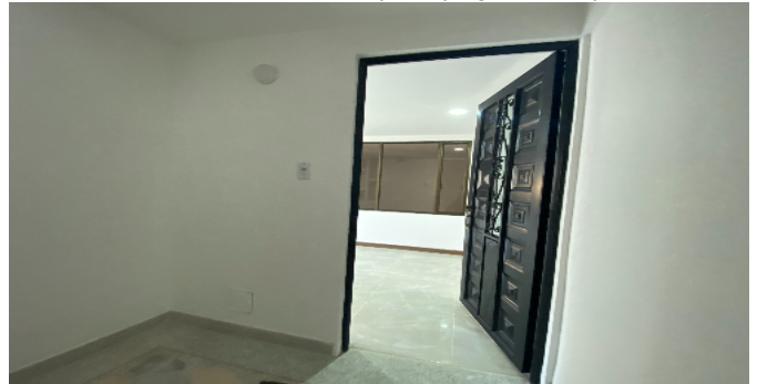
Puerta de Entrada Apto 1 (Segundo Piso)
