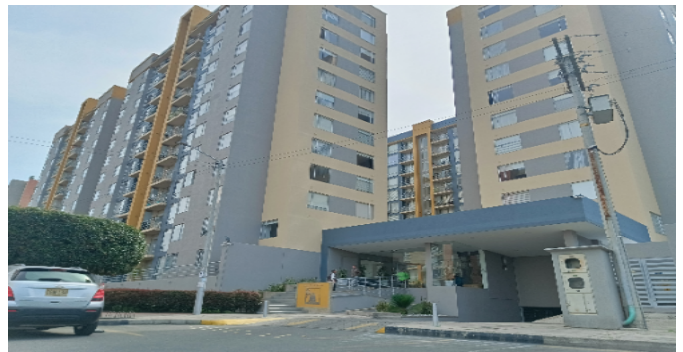
Fachada del Inmueble
