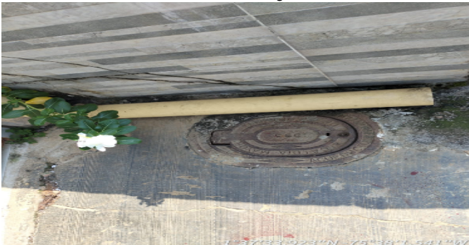
Contador de Agua
