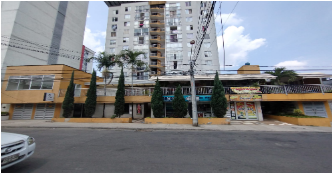
Fachada del Inmueble
