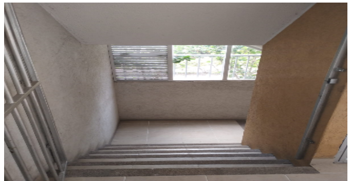
Escalera común - CJ
