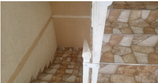
Escalera común - CJ
