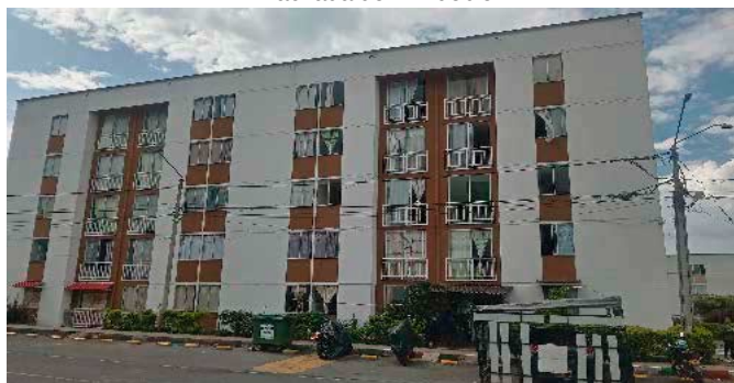
Fachada del Inmueble
