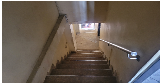
Escalera común - CJ
