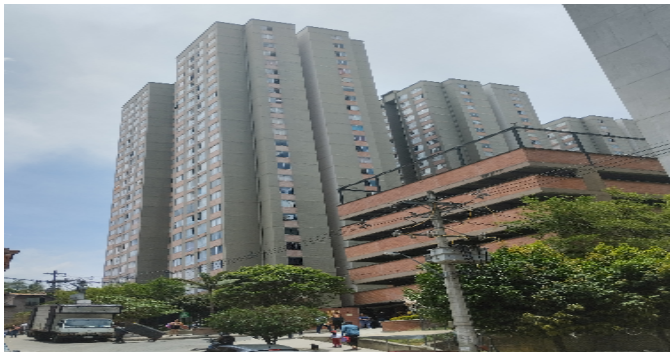
Fachada del Inmueble
