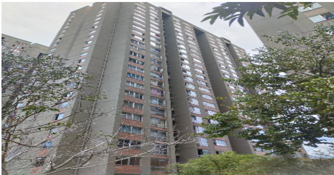
Fachada del Inmueble
