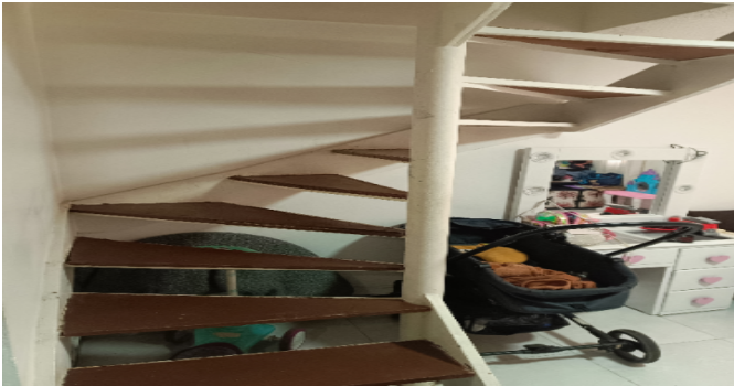
Escalera del inmueble
