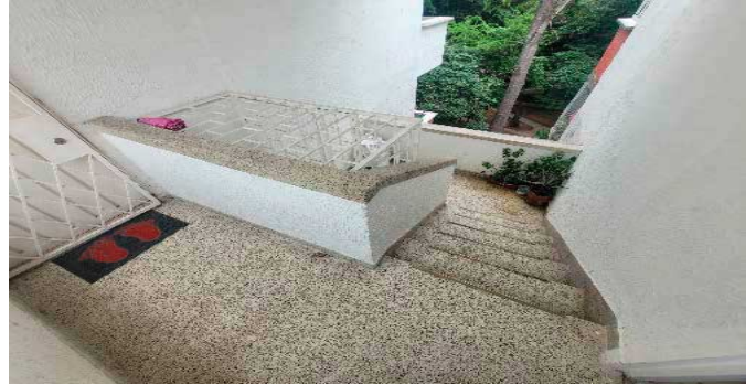
Escalera común - CJ
