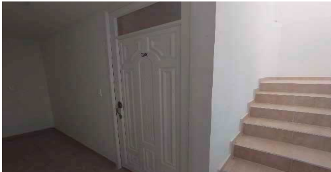
Escalera común - CJ
