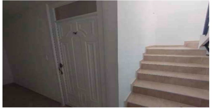
Escalera del inmueble
