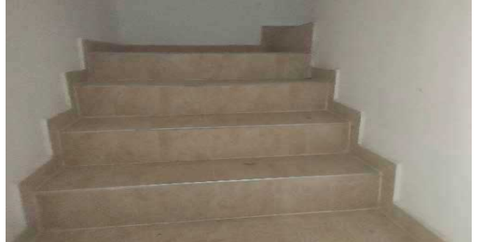
Escalera común - CJ
