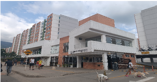
Fachada del Inmueble
