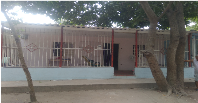
Fachada del Inmueble
