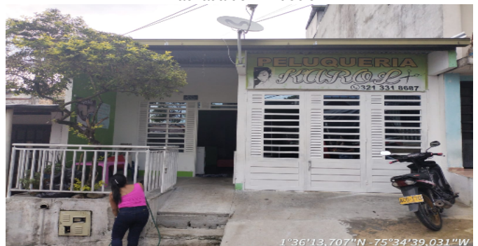
Fachada del Inmueble
