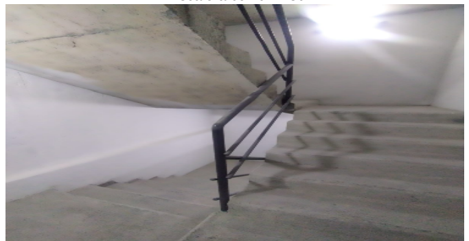
Escalera común - CJ
