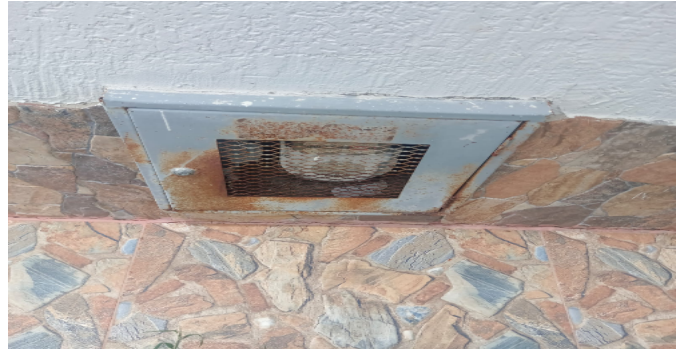
Contador de Gas
