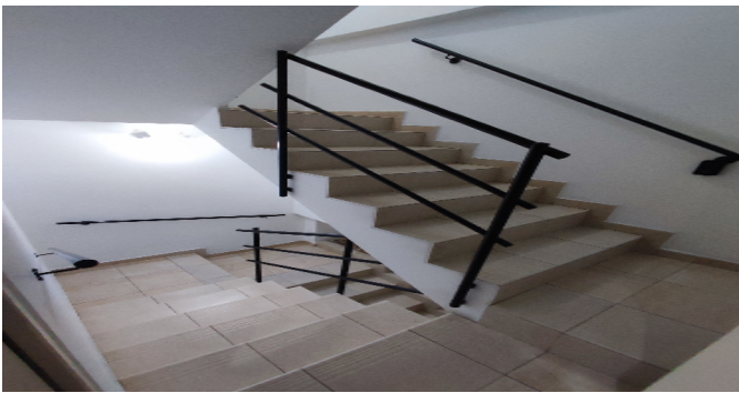
Escalera común - CJ
