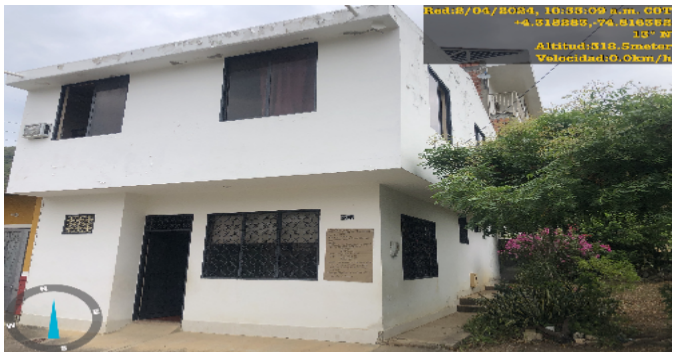
Fachada del Inmueble
