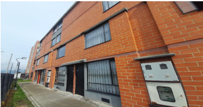
Fachada del Inmueble
