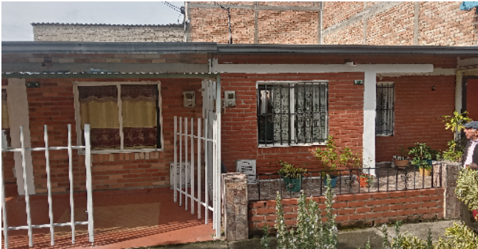
Fachada del Inmueble
