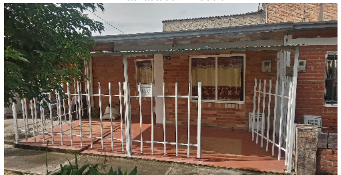
Fachada del Inmueble
