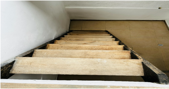
Escalera del inmueble
