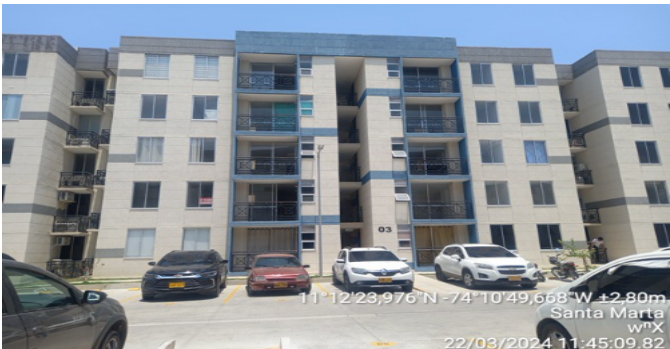
Fachada del Inmueble
