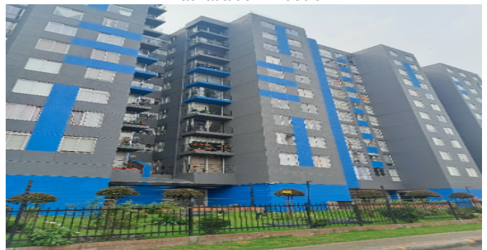
Fachada del Inmueble
