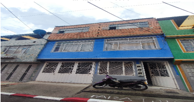
Fachada del Inmueble
