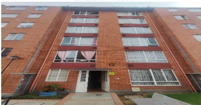
Fachada del Inmueble
