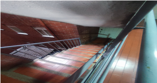
Escalera del inmueble
